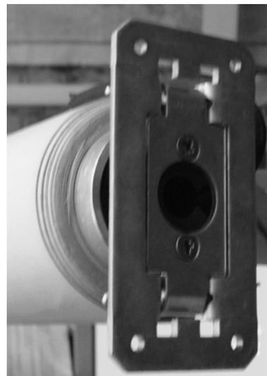
Рис. 2. Крепление трубы с намотанным на трубу экраном
