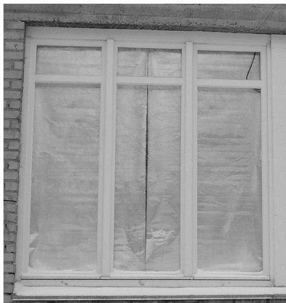
Рис. 5. Экспериментальный оконный блок АлтГТУ с управляемыми теплотехническими характеристиками по технологии УЭВС с закрытым экраном (вид снаружи)
